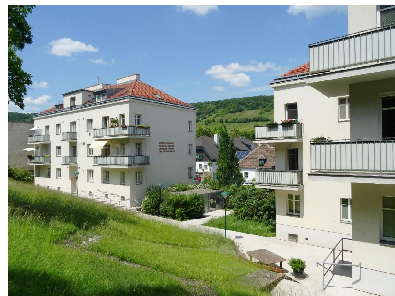
Wohnhausanlage Wien 19, Neustift am Walde 69-71
